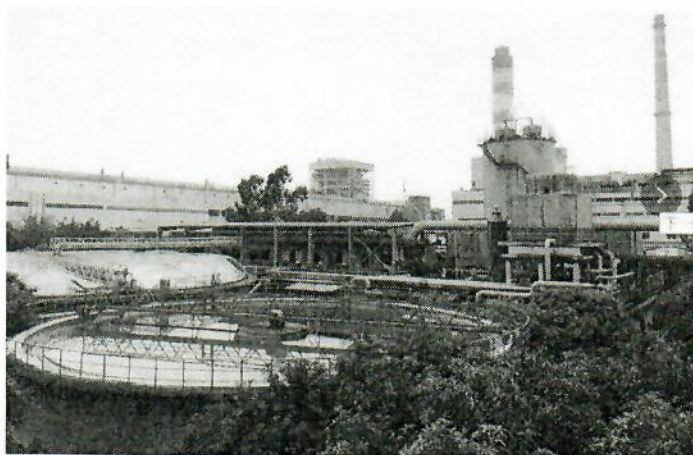
图 3 污水处理设施
